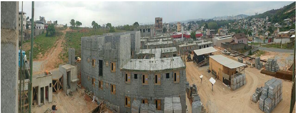
Figura 6 Visão panorâmica do empreendimento. Fonte: Construtora (Outubro, 2016).
